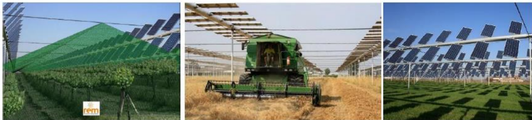
Photos de projets avec la technologie REM TEC sur tracker bi-axes (crédits photographiques : REM Tec, 2020).
