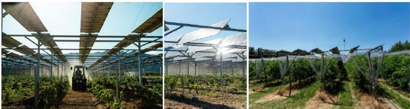
Photos de projets avec la technologie de panneaux pivotants mono-axes développées par SUNAGRI
