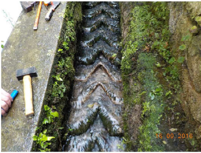
Passes à poissons concrétionnée (Mue)
